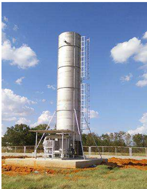
Рисунок 13 – Факельная установка закрытого типа
