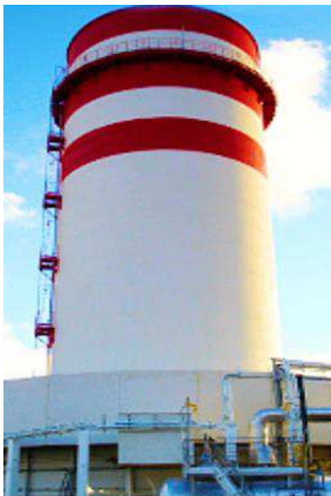
Рисунок 2 – Факельная установка закрытого типа
