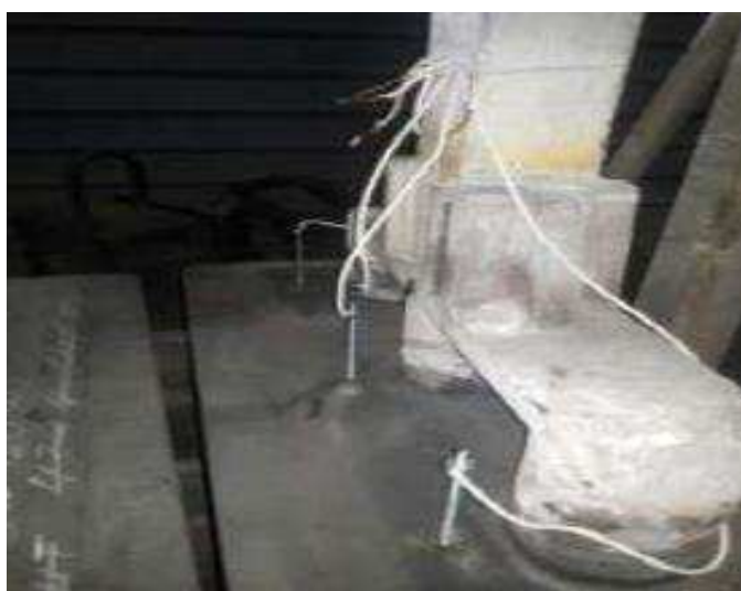
Рисунок 12 – Предварительное засверливание анодов и установка в тело анода трех токоподводов
