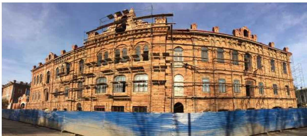
Рисунок 42. Общий вид на фасад после проведения реставрационных работ (22.10.2019г.)
