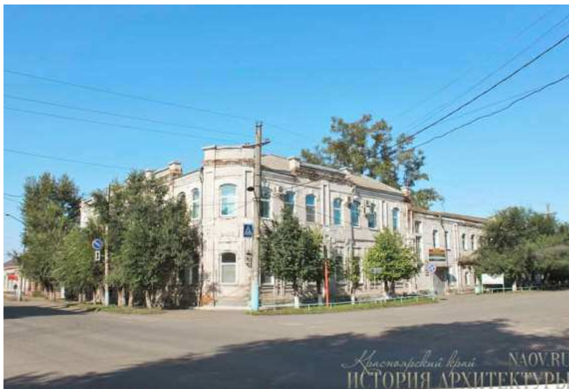
Рис. 12 Жилой дом Н. П. Пашенных по ул. Октябрьская, 36 [39]
