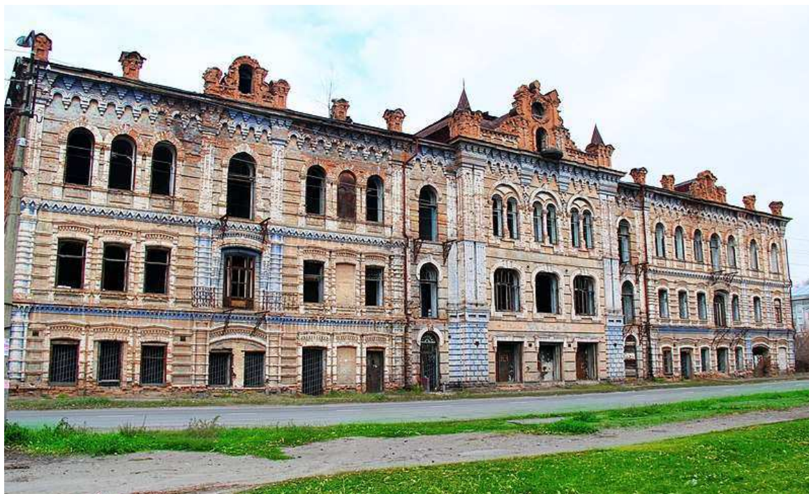
Рисунок 41. Общий вид на фасад до начала реставрационных работ (06.08.2013г.)
