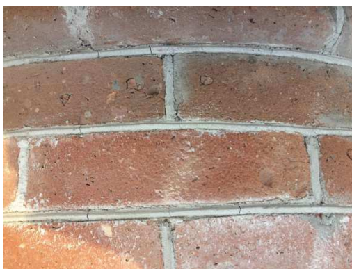
Рис. 7 Участок отчищенной от высолов кладки
