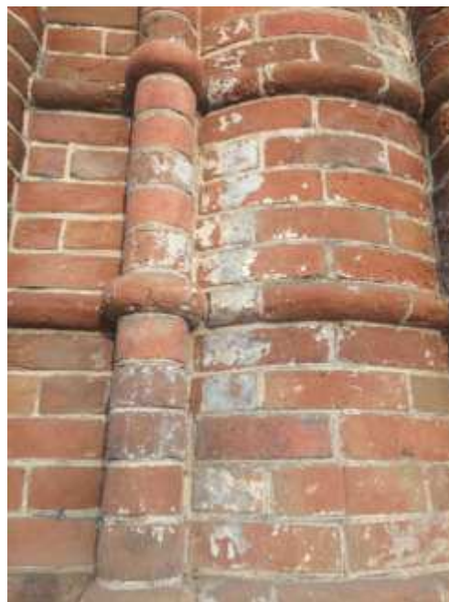
Рис. 6 старый слой штукатурки выполненной еще во времена строительства дома
