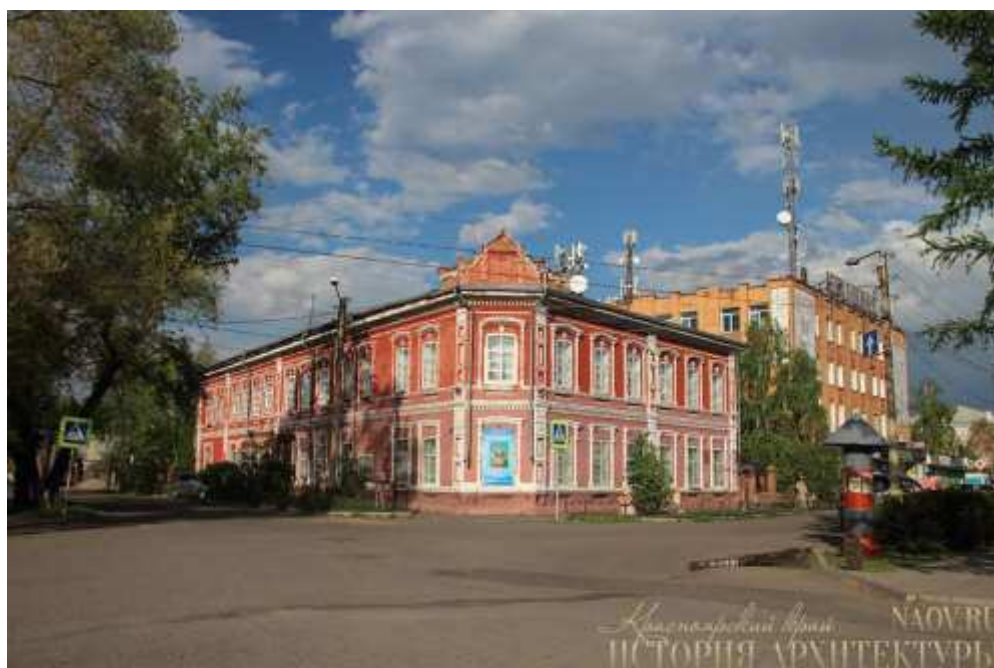
Рис. 5 Жилой дом по ул.Ленина, 77 [39]
