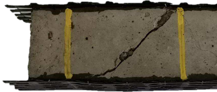
Рисунок 3.15 – Разрушение образца по наклонным трещинам
