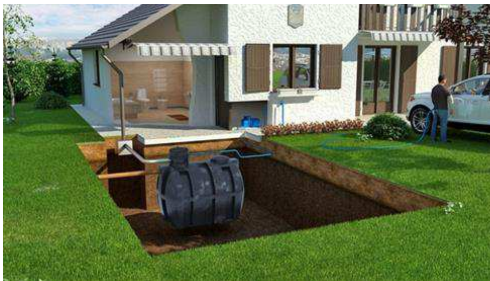
Рисунок 13 – Установка накопительной емкости с углублением в грунт
