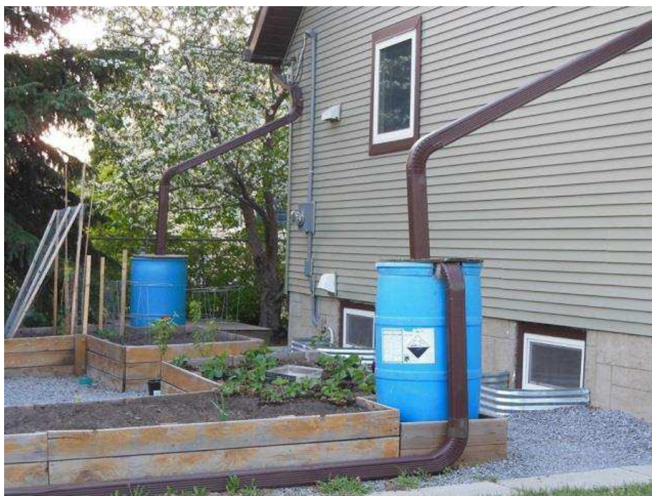
Рисунок 11 – Установка накопительной емкости на поверхности
