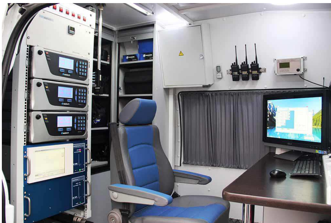
Рисунок А2 – Мобильная станция. Вид внутри
