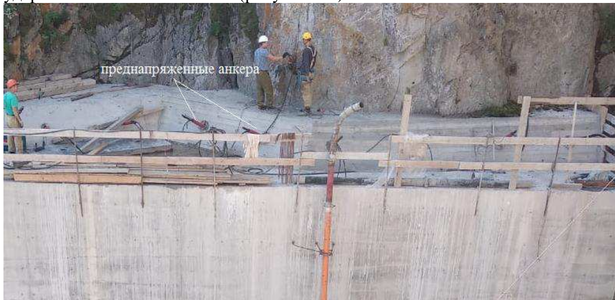
Рисунок 8.3 – Анкерный пояс с преднапряженными анкерами, удерживающий скальный массив
