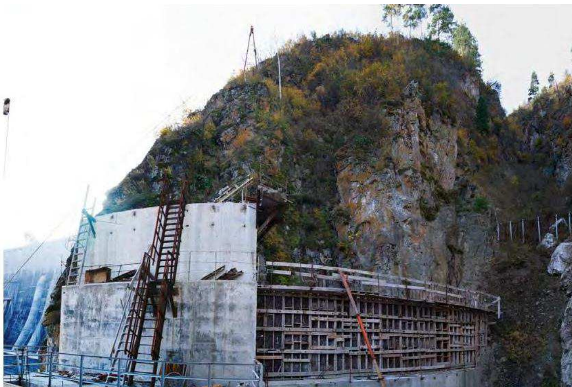
Рисунок 8.2 - Вид на ПНБ на левобережном примыкании плотины Саяно-Шушенской ГЭС
