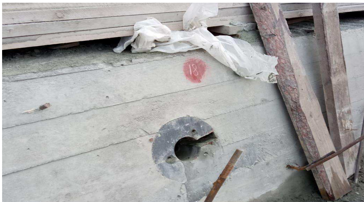
Рисунок 8.6 – Готовая скважина для установки преднапряженного анкера
