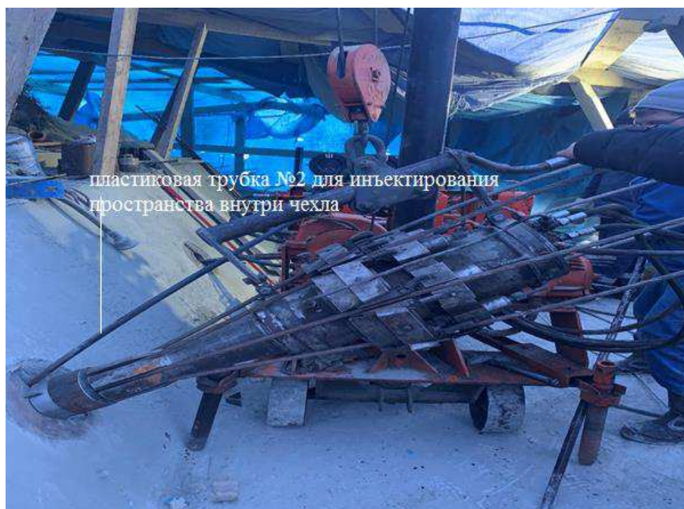
Рисунок 8.11 – Работы по натяжению преднапряженного анкера, при помощи такелажного приспособления кран-тележки домкрат одет на анкер, стальные пряди распределены по трубкам тянущей обоймы
