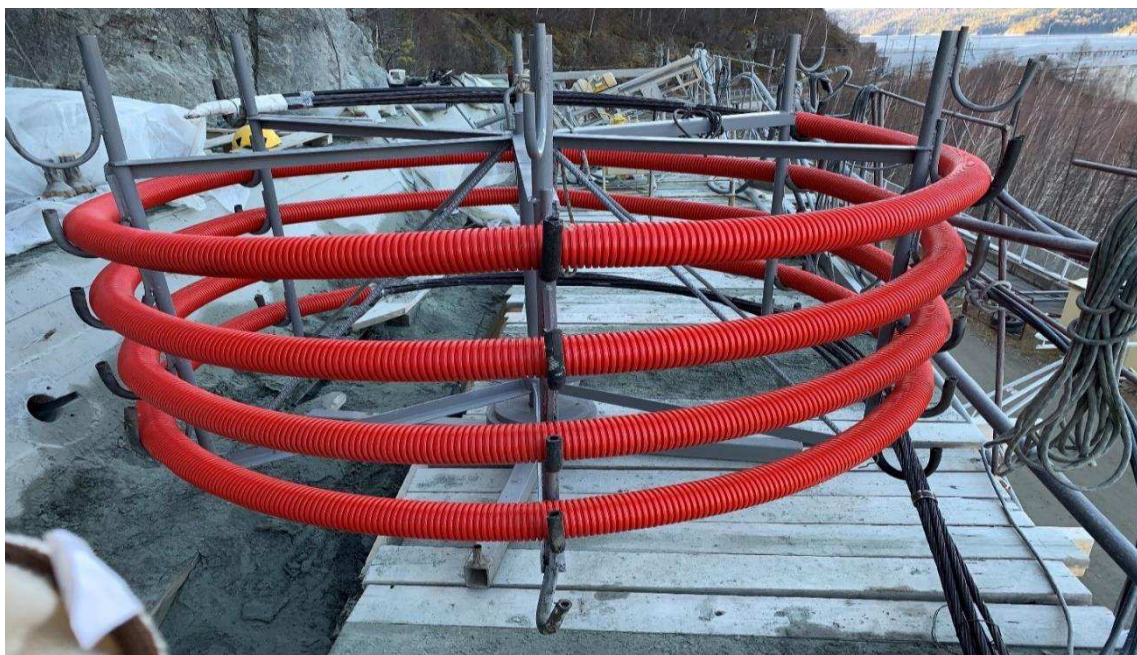
Рисунок 8.7 –Преднапряженный анкер готовый к установке
