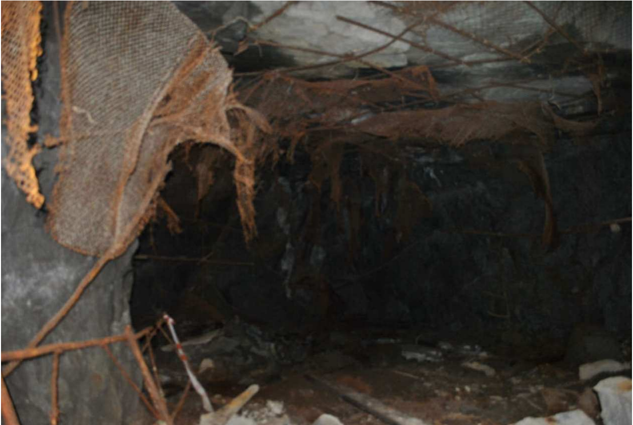
Фото 9.5. Ниша под оборудование на ПК1+33,00. Состояние крепления свода
