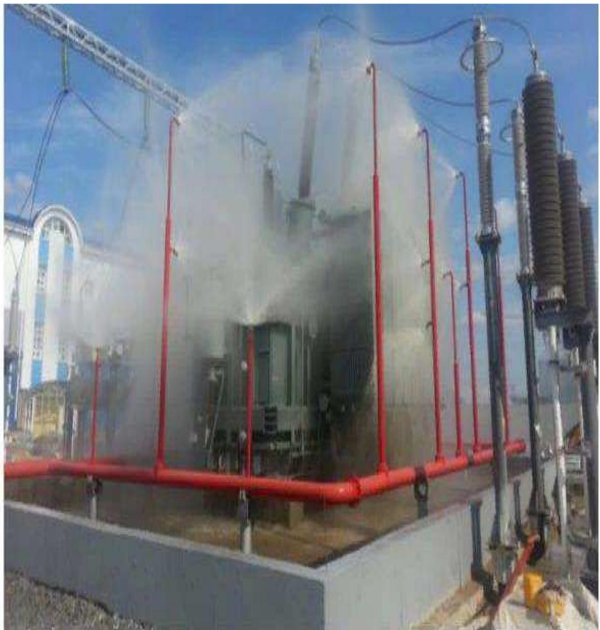
Рисунок 38 – Система водяного пожаротушения трансформатора в работе
