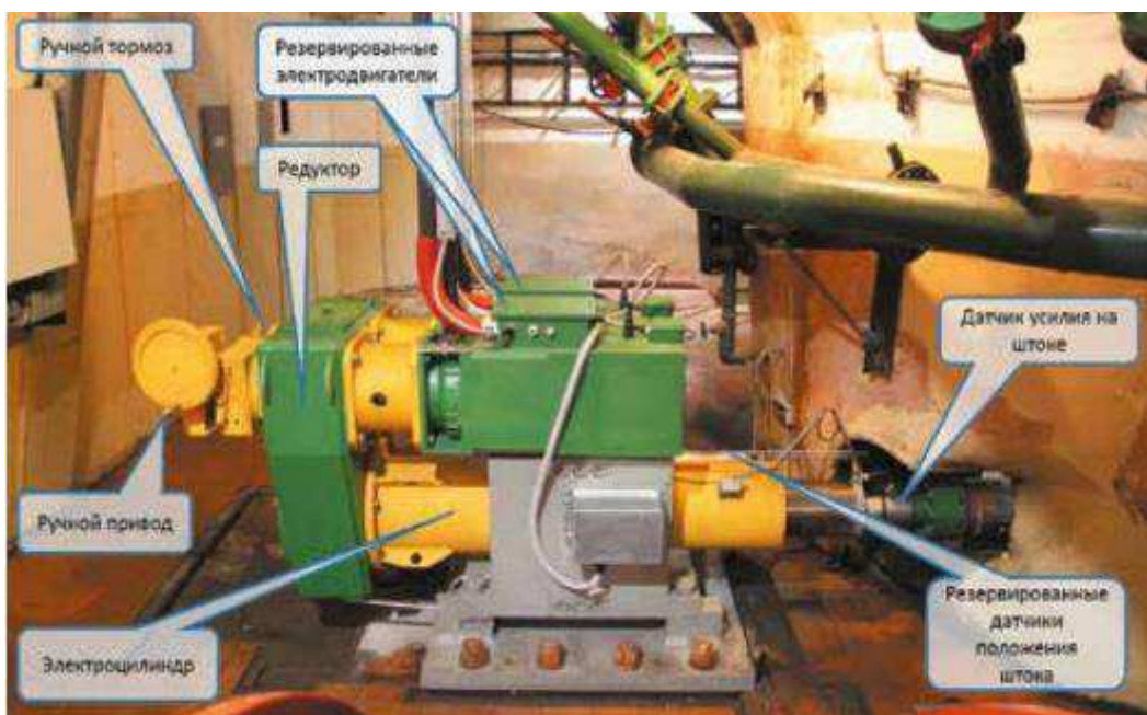
Рисунок 9.5 – Общий вид электроцилиндра для управления НА
