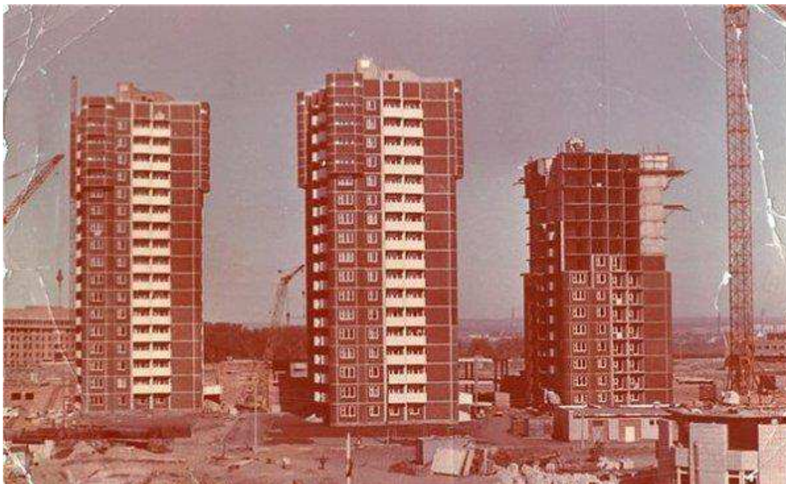
Рисунок 1. Строительство микрорайона «Взлётка» в 1990-е гг. 181
