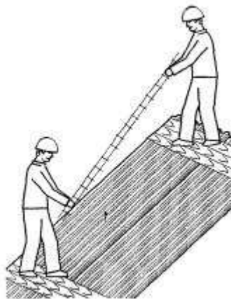
Рисунок 5.3.6 – Раскладка арматурных стержней в гофры.
