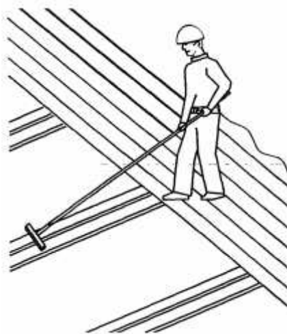
Рисунок 5.3.1 – Очистка балок перекрытия.
