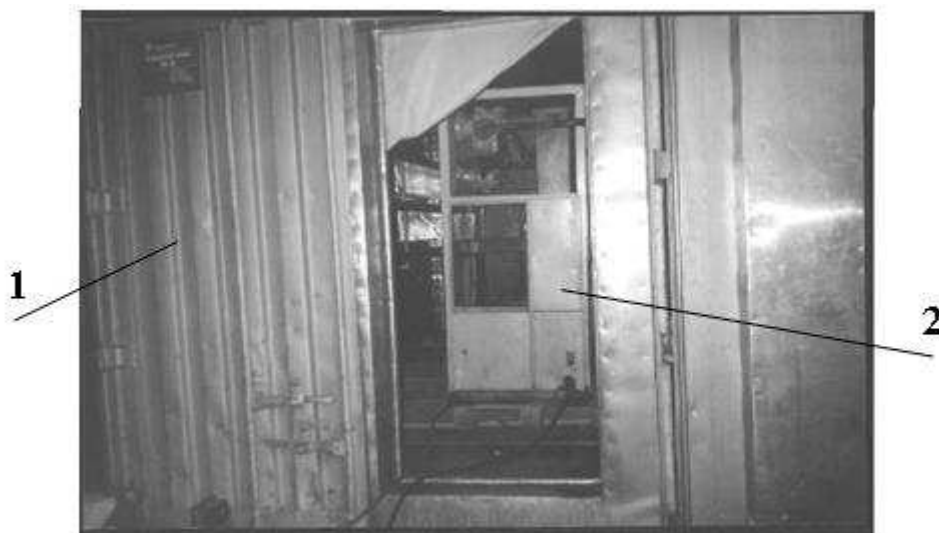
1 – холодильная камера КХ-23 ТОО «Эдельвейс»; 2 – стенд КИ-4815М Рисунок 3.3 - Общий вид стенда
