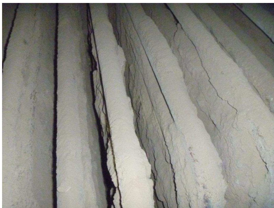
Рисунок 1.3 – Зашлакованный КПП котельного агрегата П-67 БГРЭС
