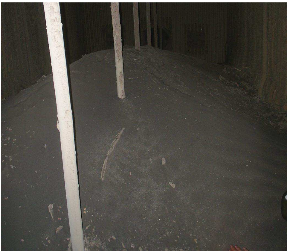
Рисунок 1.4 – Золовые отложения на поверхности конвективного пароперегревателя
