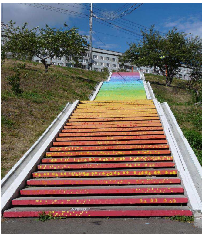
Рисунок Г.16. Лестница на левобережной набережной Красноярск. – общий вид.
