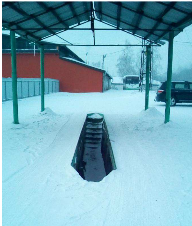
Рисунок 1.1 – Пункт осмотра предрейсового выпуска автобусов
