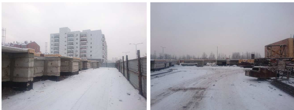
Рисунок 41 – Общий вид на строящийся объект в период 22.12.2018 года.
