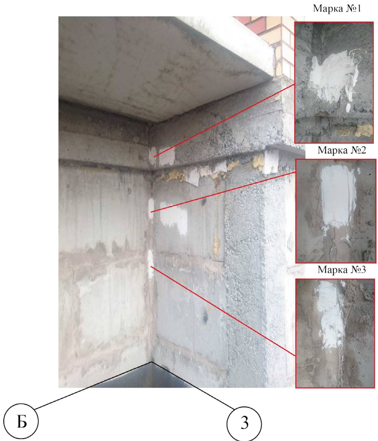
Рисунок 48 – Места установки марок для ведения мониторинга.
