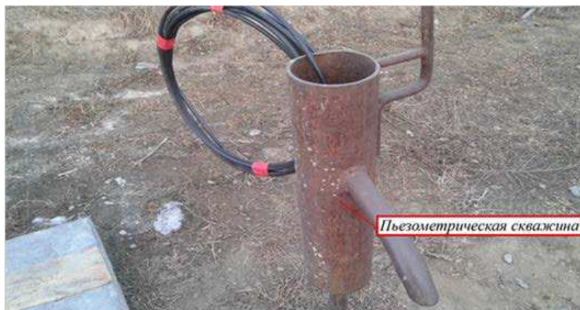
Рисунок 31 – Измерение УГВ в пьезометрической скважине.
