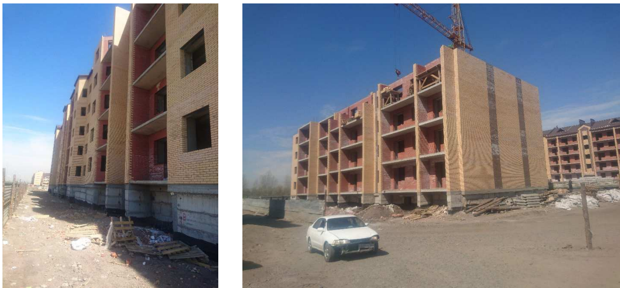
Рисунок 42 – Общий вид на строящийся объект в период 18.05.2019 года.
