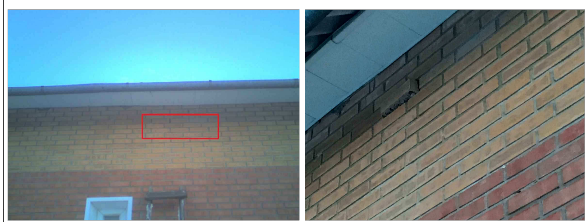
Первоначальное состояние обследуемого участка здания.
