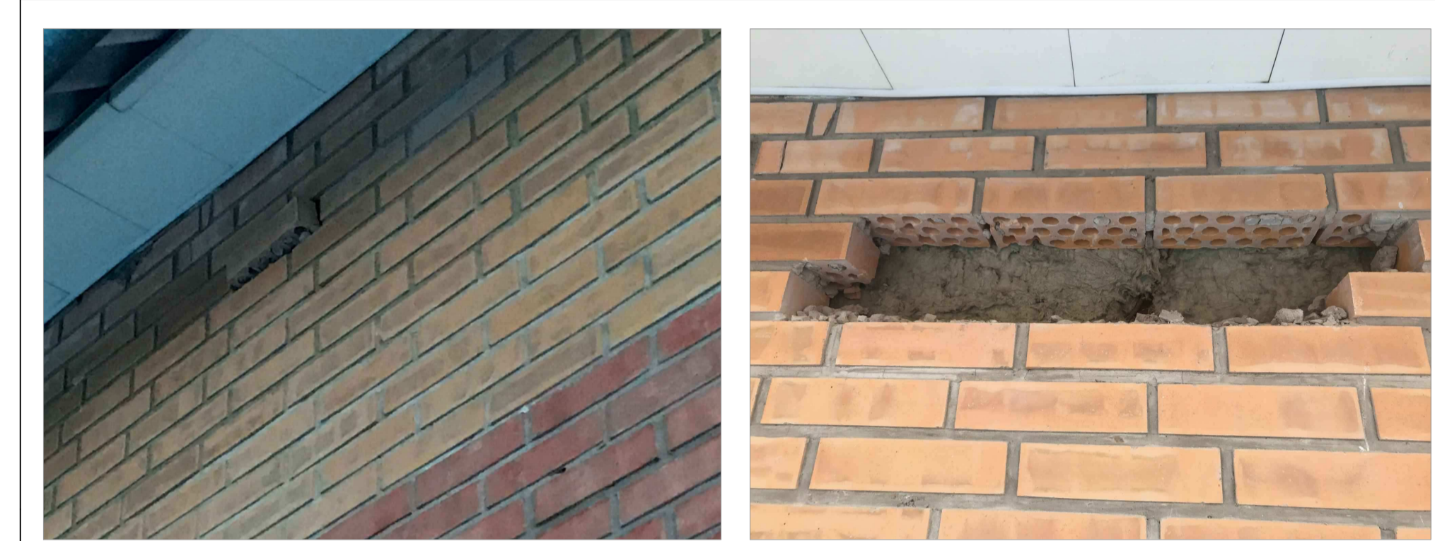
Вскрытие облицовочной кладки карнизного узла.
