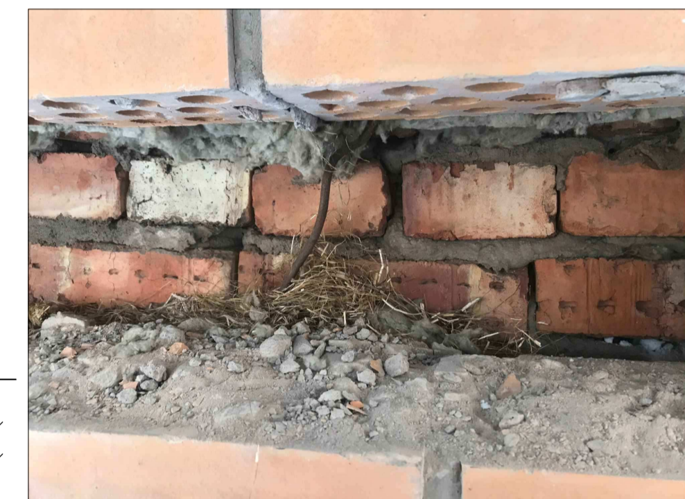
Дефекты кирпичной кладки: неоднородность швов, наличие пустот между кирпичами.
