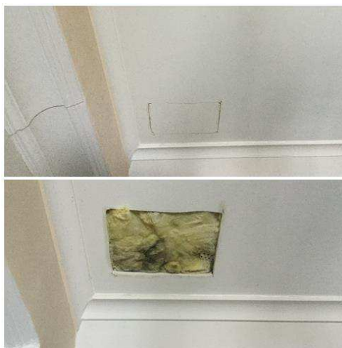
Рисунок 4 – Вскрытие финишной отделки из ГКЛ.
