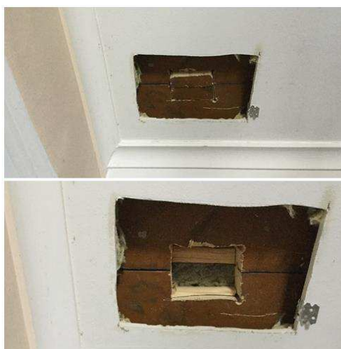
Рисунок 6 – Вскрытие слоя кровли из шпунтовых досок.
