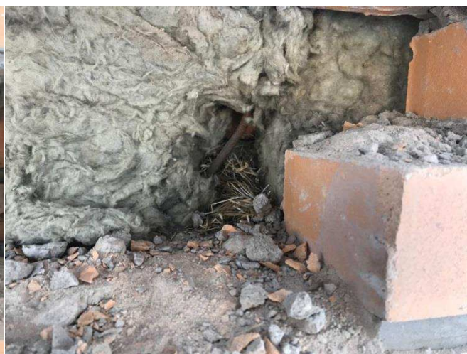
Рисунок 14 – Неоднородность и низкое качество теплоизолирующего слоя ограждающей конструкции.
