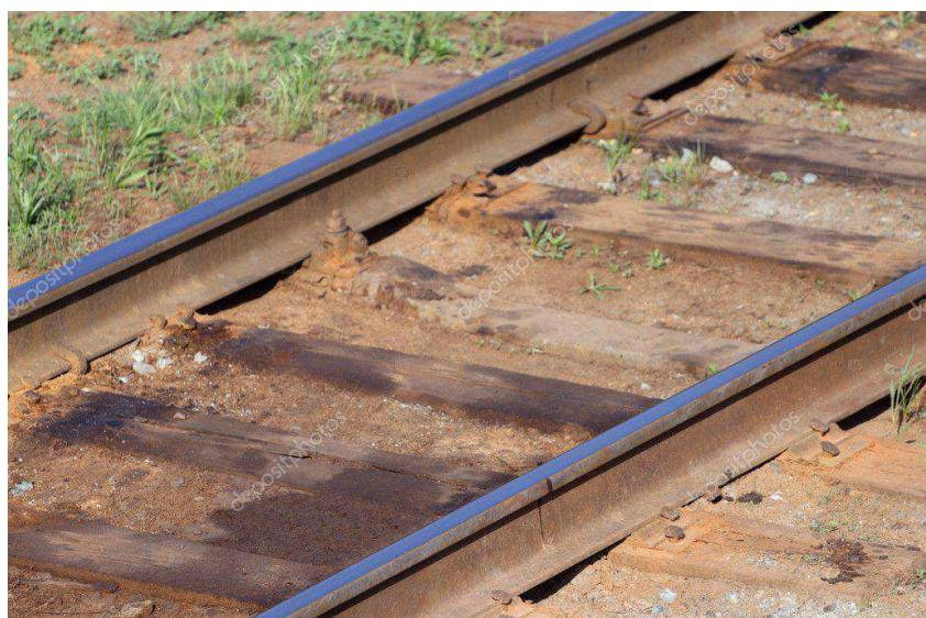
Рисунок 18 – Загрязнение рельс пластичным смазочным материалом
