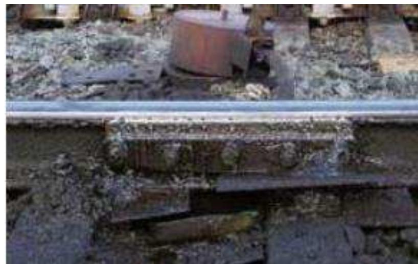
Рисунок 13 – Замасливание рельс
