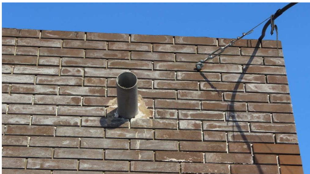
Рисунок 3.3.2.2 – Выпуск водосливной трубы за контур здания
