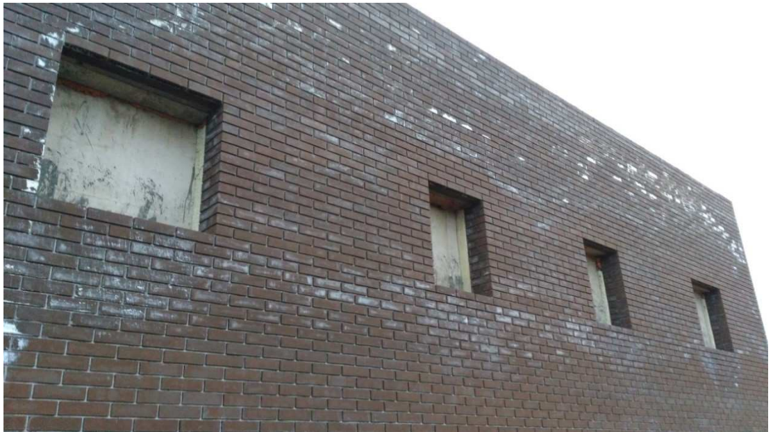
Рисунок 3.5.1 – Северный торец здания лаборатории
