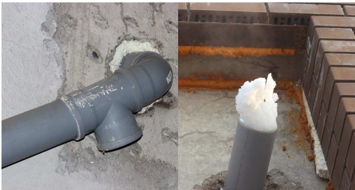
Рисунок 3.4.1.1 – Временная вентиляция
