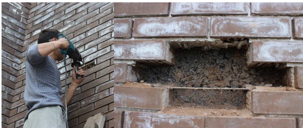
Рисунок 3.5.7 – Демонтаж разрушенного лицевого кирпича на восточном торце здания лаборатории
