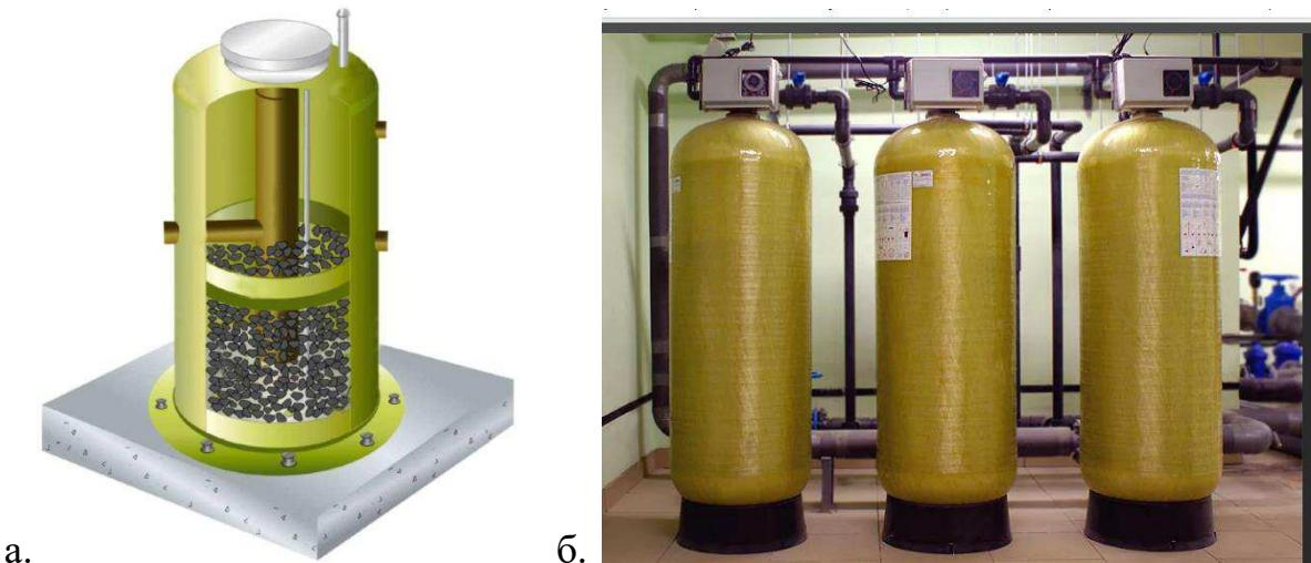
Рисунок 6 – а. – Модель фильтра с угольной загрузкой; б. – Производственные угольные фильтры
