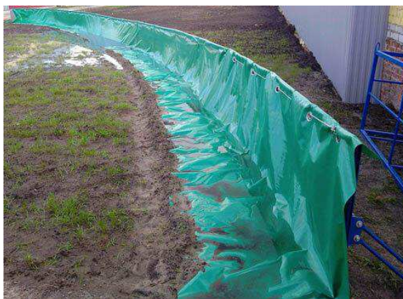
Рисунок 6 – Подпорная стенка ПС-0,75
