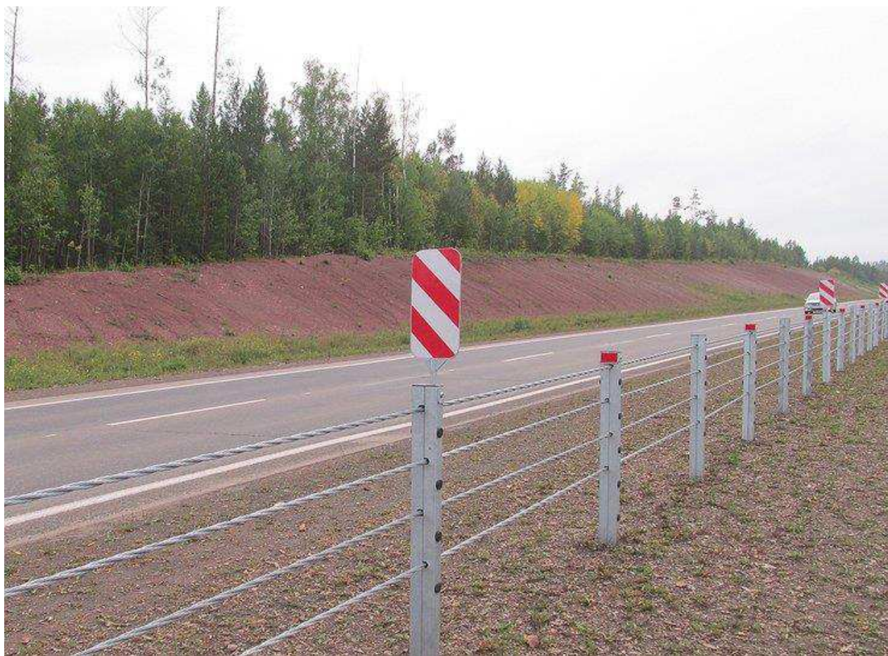
Рисунок 2.21 – Вид дорожного ограждения тросового типа
