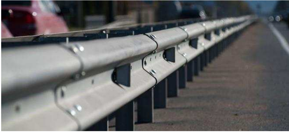
Рисунок 46 – Ограждение мостовое двустороннее типа «11–МД» для разделения встречных потоков
