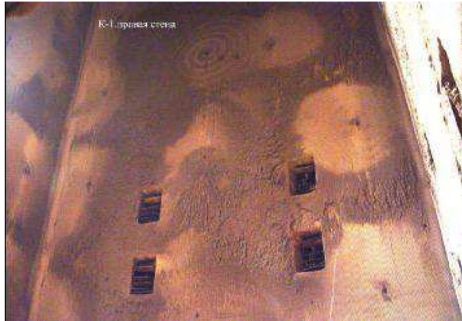
Рисунок 3.4 – Характер шлакования топочных экранов котла П-67 (зона третьего и четвертого ярусов горелок и выше)
