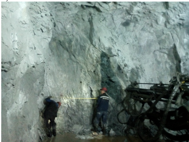
Рисунок 1 – Практика ведения буровзрывных работ на рудниках
